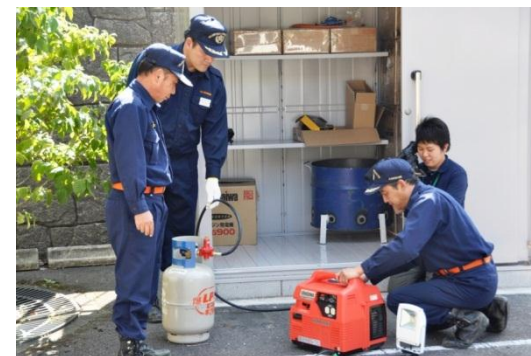
LPガス発電機の整備(川上村)
